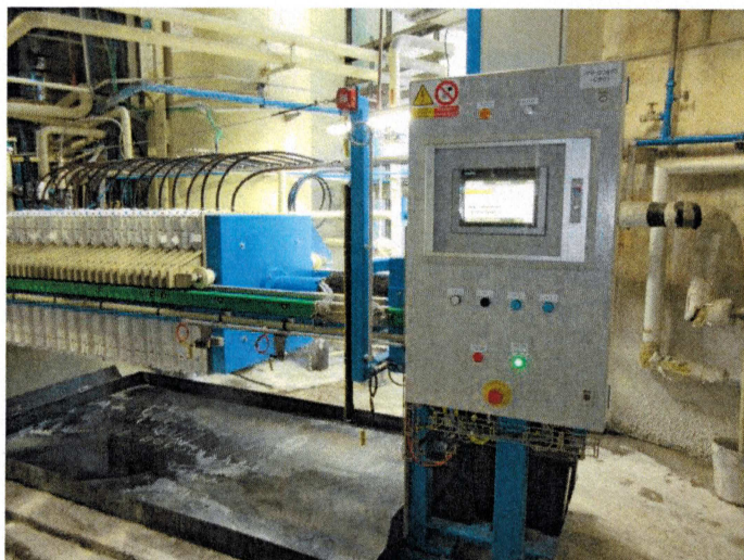
Kalolis na filtraci silikátů
